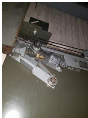
Serrure de porte palière du niveau principal
