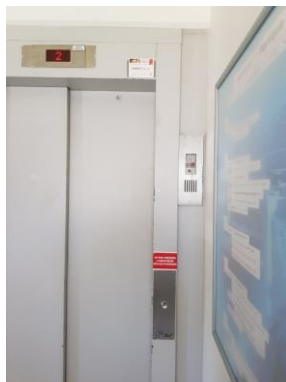
Commande palière du niveau principal
